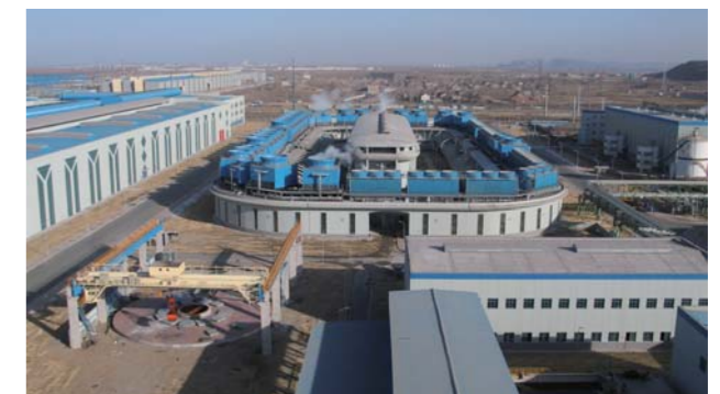
▲ 综合水处理中心
