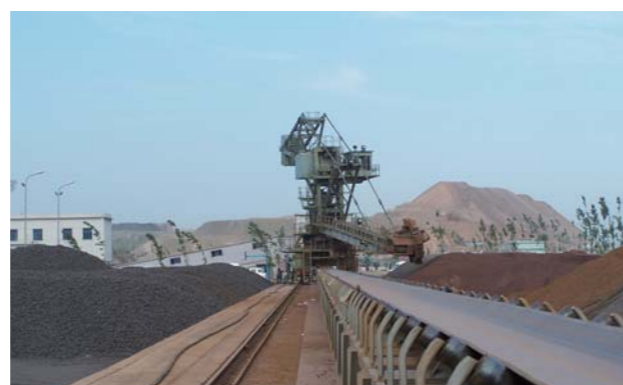
▲ 高炉块矿料场
