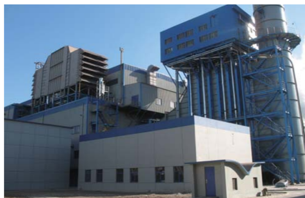
▲ 150MW燃气-蒸气联合循环发电（CCPP）
